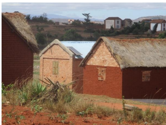
Utilisation de panneau solaire à Ambohibola
