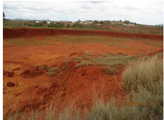
Site de confinement (vue Sud-ouest)
