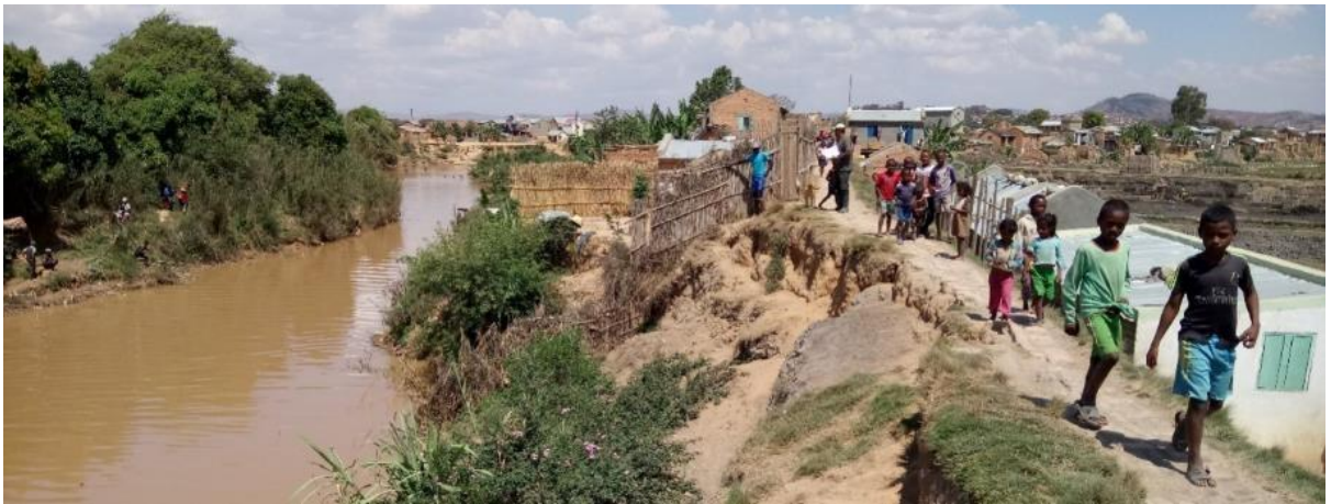
Fig. 1. Vues du périmètres des travaux (Canal C3 et Digue Sisaony)
