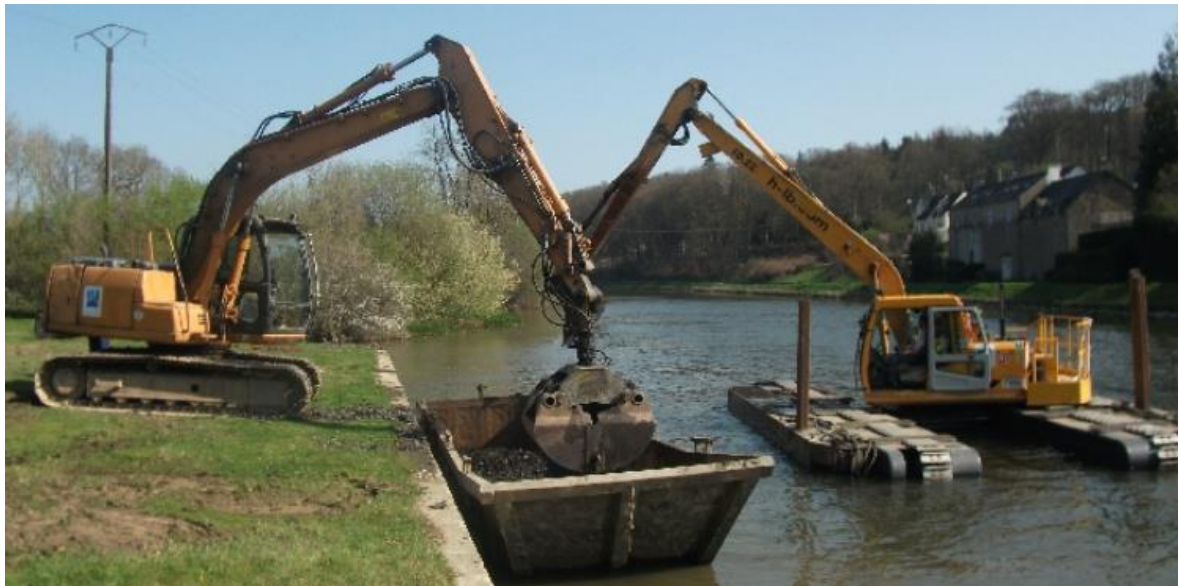
Fig. 10. Curage mécanique par pelle sur berge ou sur ponton
