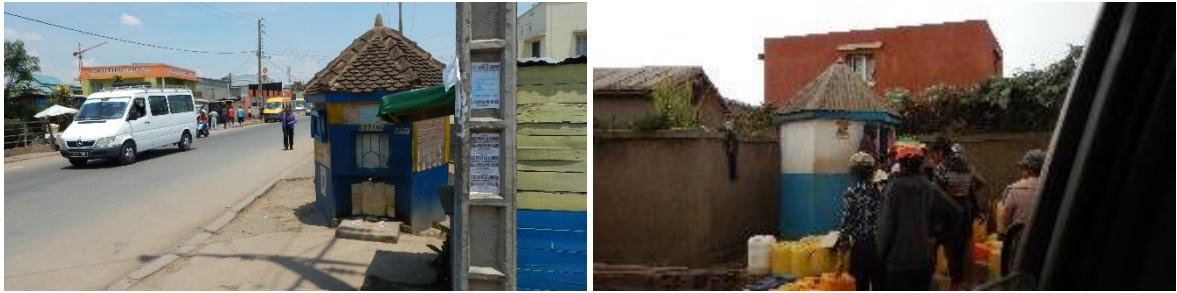
Fig. 54. Bornes fontaines dans la zone d'étude immédiate
