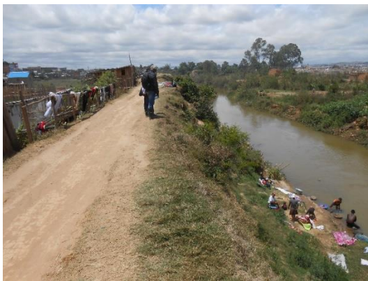
Ikopa rive gauche - Zone amont pont
