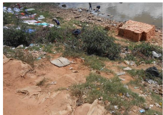
Ikopa rive droite - restes de blocs en pied
