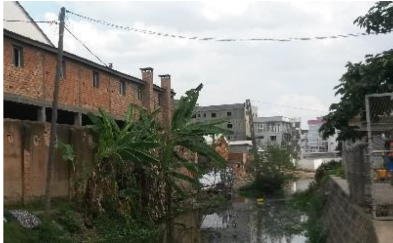
Fig. 77. Poteaux électriques de la JIRAMA à déplacer
