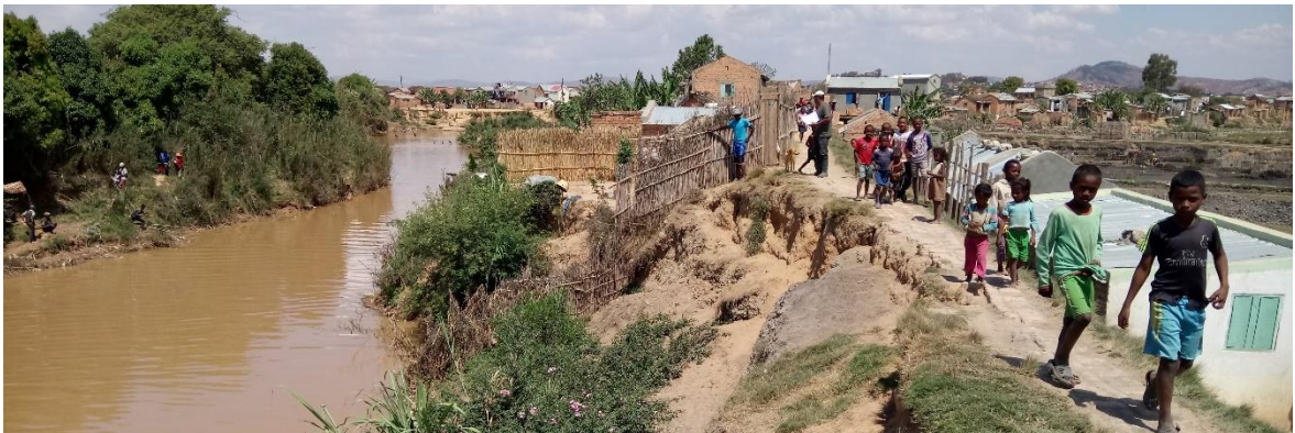
Fig. 3. Vues du périmètre de travaux (Canal C3 et Digue Sisaony)
