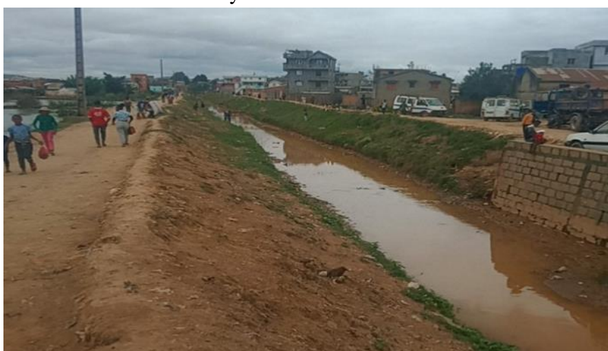
Passerelle fokontany Ambodivona PR-AZATO/F2/PASS1
