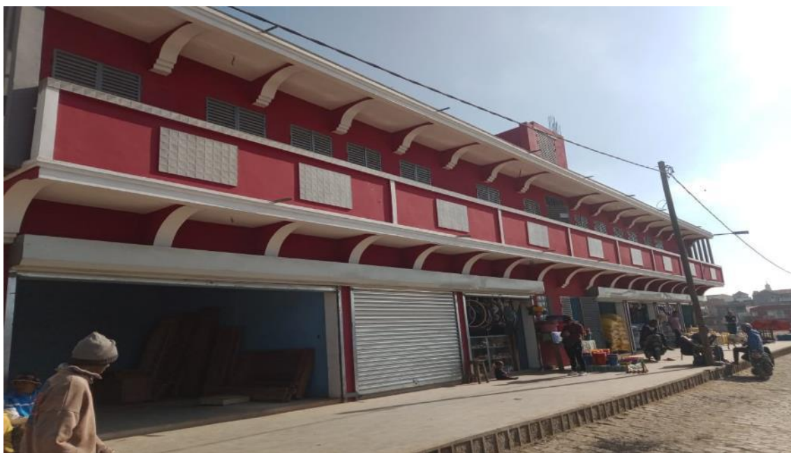
Photo 5 : Base-vie secondaire et bureau de chantier
