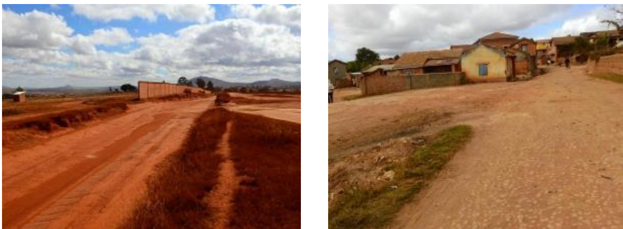
Photo 9: Site de la piste à réhabiliter à Ambatomitsangana (début) et à Ambatomainty (fin)
