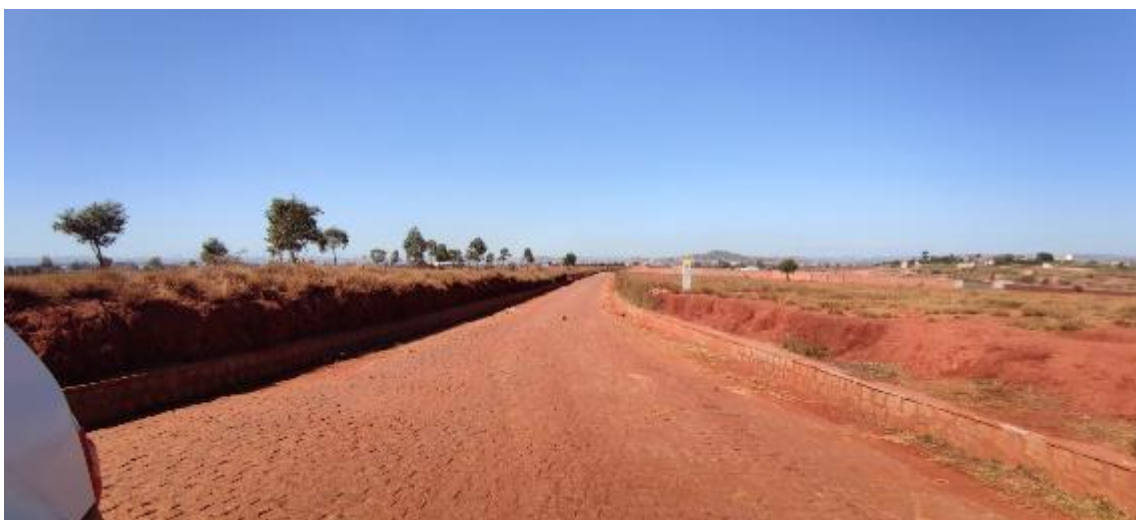
Route en pavé, au niveau d'Ambatomitsangana, à l'entrée de la Commune
