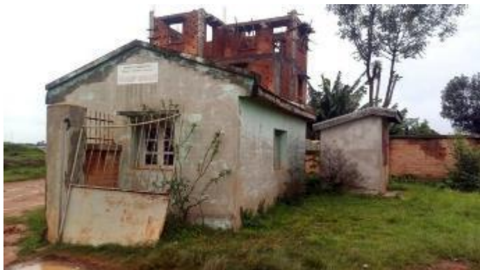
Photo 8 : Local qui va servir de bureau de chantier à Iarinarivo
