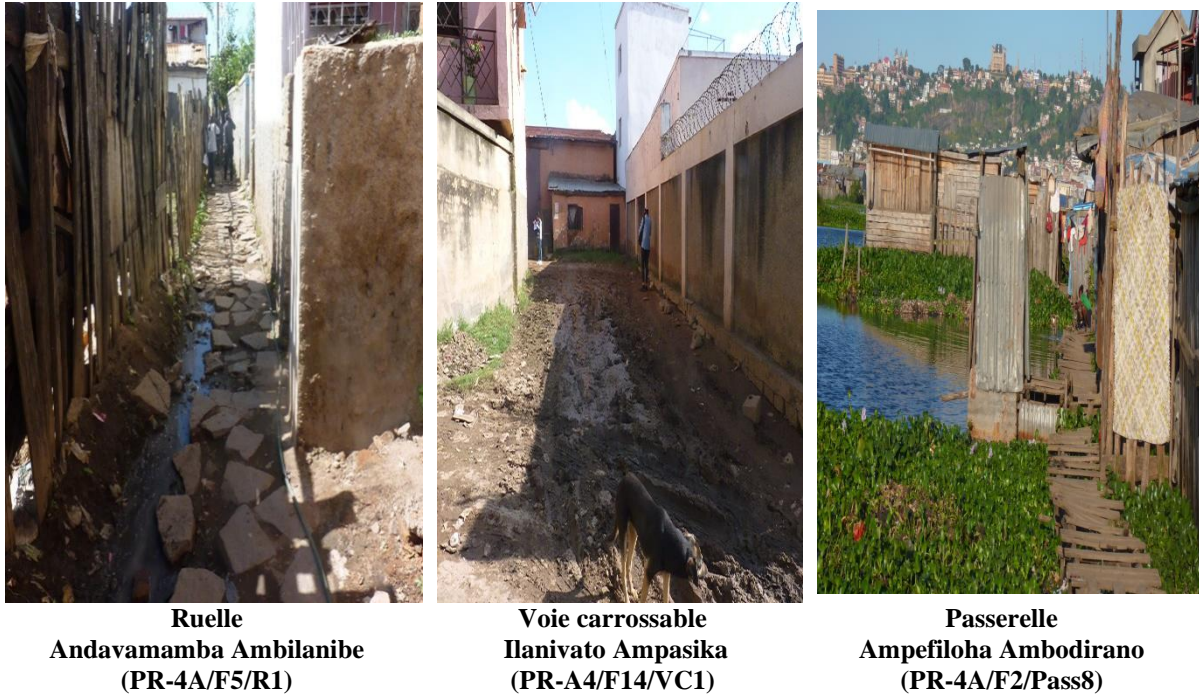
Photo 1 : Quelques infrastructures types à réhabiliter dans le cadre du Sous-projet TRAVAUX URBAINS Phase 2, lot 2
