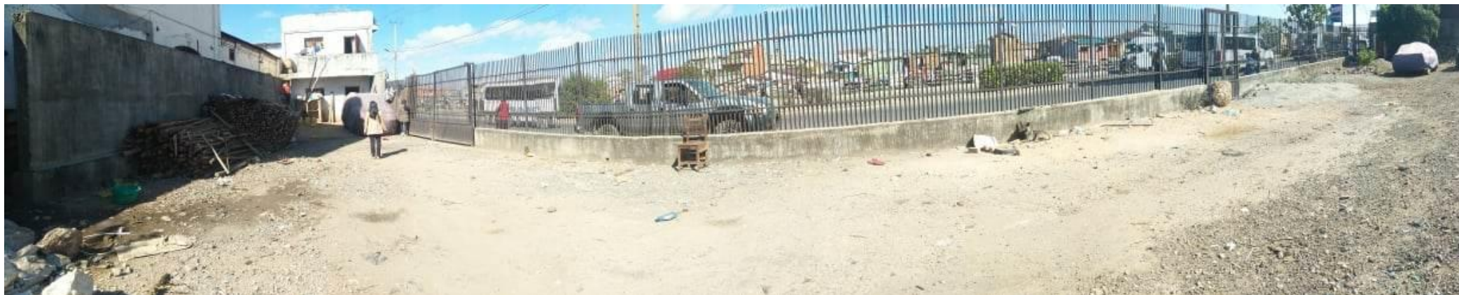
Photo 3: Base chantier sis à Mananjara
