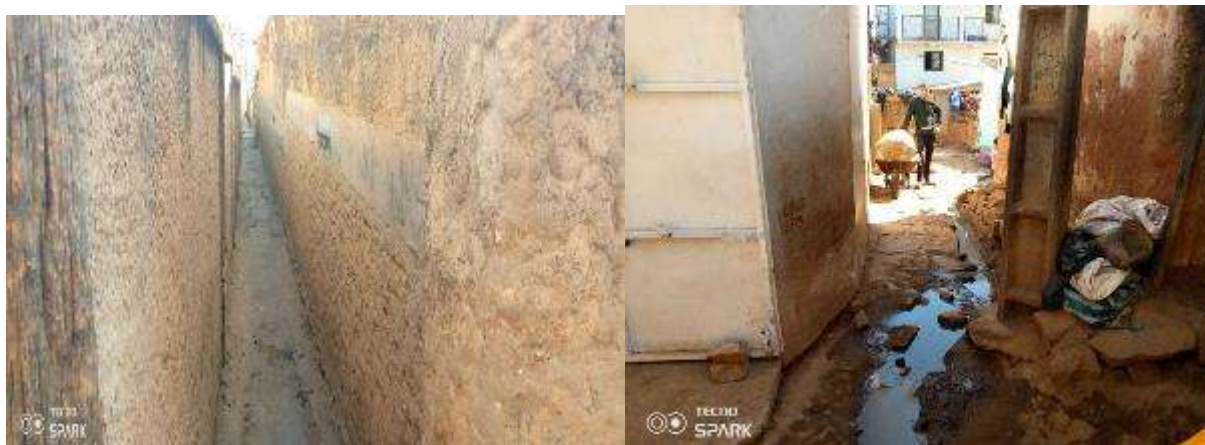
Photo N° 1 : Ruelles à réhabiliter/Juillet 2023
